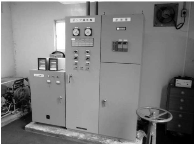
施設内計器類の故障は地域全体の断水になる可能性があります
