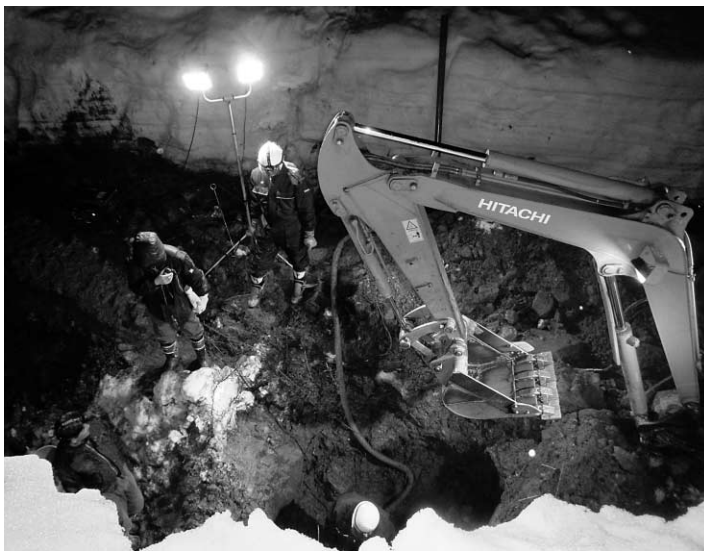
夜間行われた水道管復旧工事の様子。水道施設の故障は時間・場所に関係なく突然発生します
