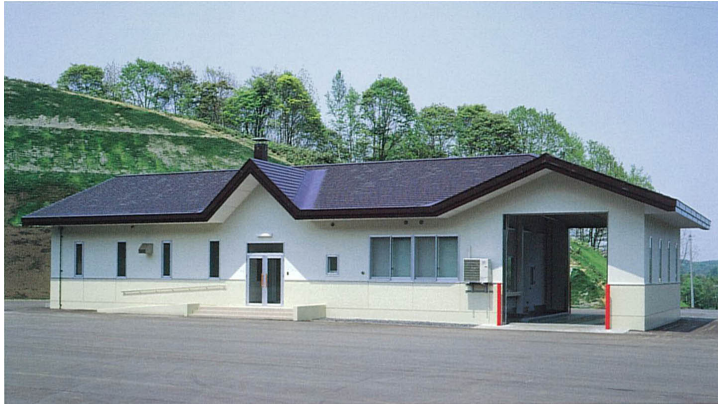
写真 3 浸出水処理施設外観
