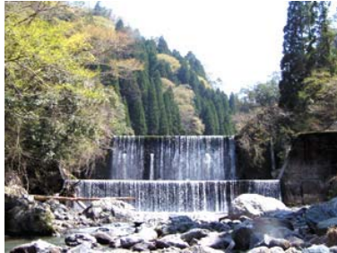
取水している砂防えん堤
