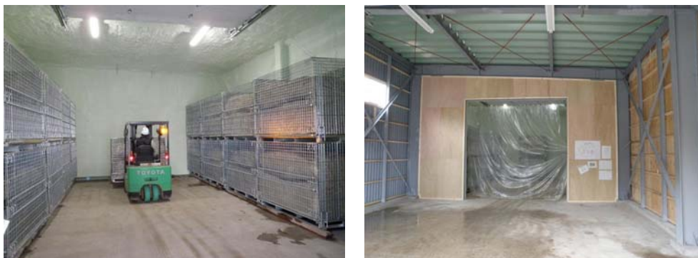
図 6-11 雪氷熱利用ユニットの設置状況（大田農場）
