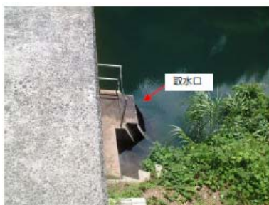
砂防堰堤（上流側）
