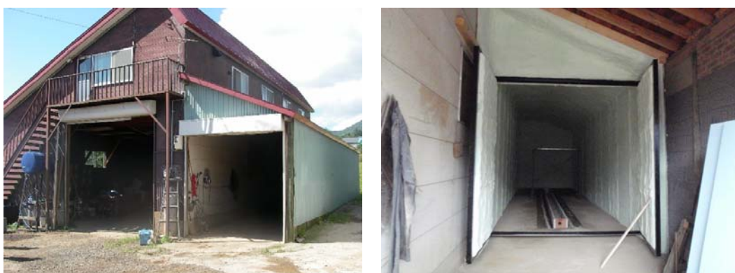
図 6-8 雪氷熱利用ユニットの設置状況（大道農場）
