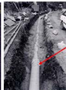
発電所導水路
