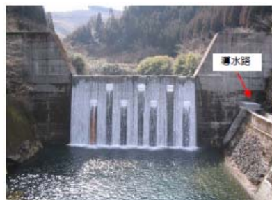
砂防堰堤（下流側）
