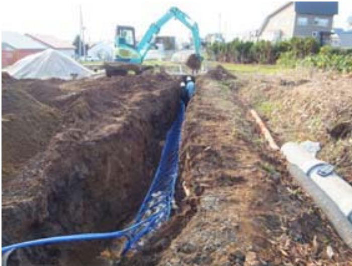
写真 2-5 水平ループ設置作業
