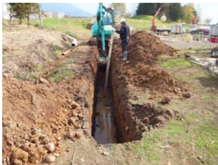
写真 2-3 水平ループ埋設用掘削
