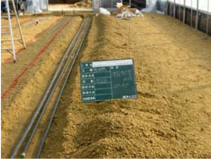
写真 2-7 ハウス内配管
