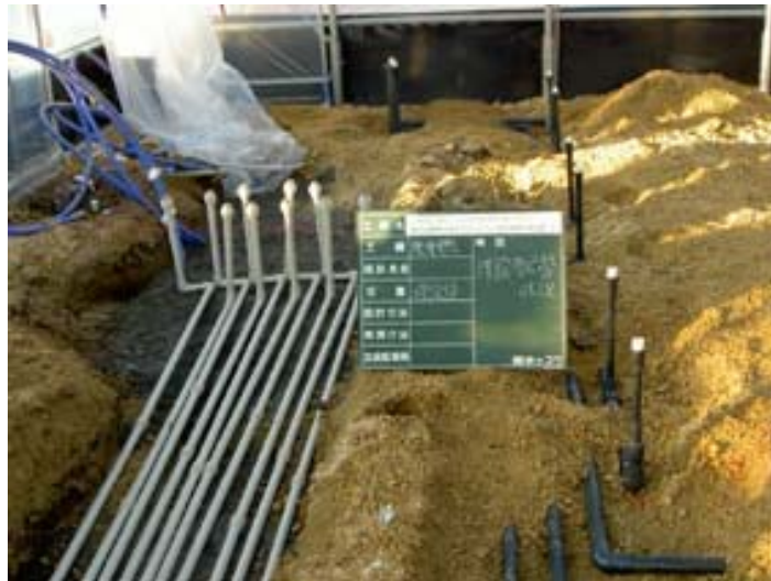
写真 2-8 ハウス内配管
