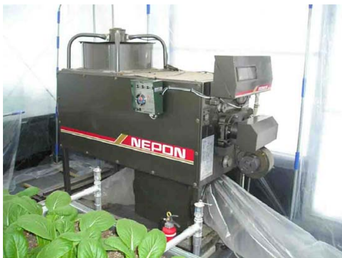
写真 2-15 予備の灯油暖房機
