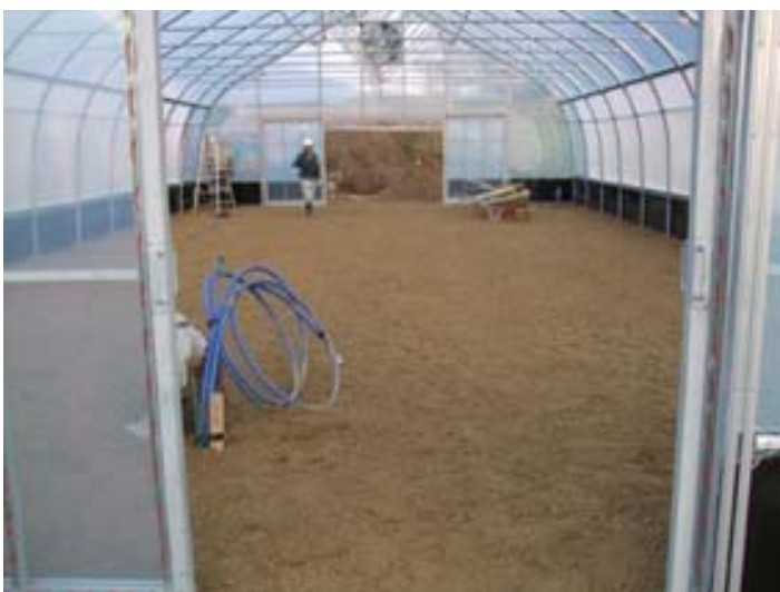
写真 2-9 ハウス内配管整備後の状況
