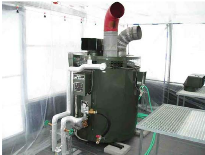
写真 2-14 熱交換温風発生機
