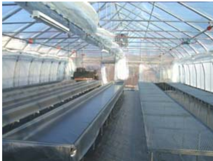
写真 2-11 土耕ベッド・高設テーブル設置
