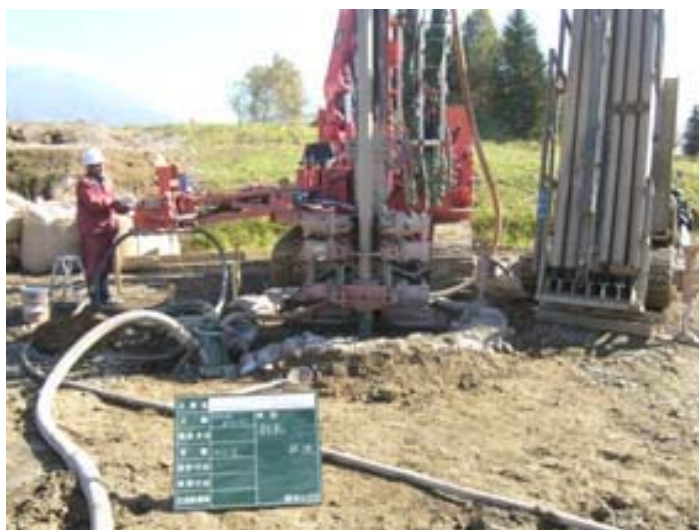
写真 2-1 Uチューブ埋設用削孔
