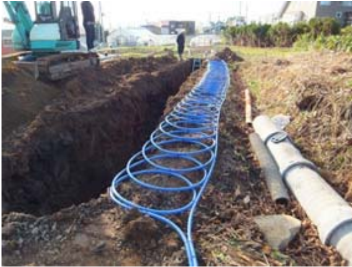
写真 2-4 水平ループ設置作業
