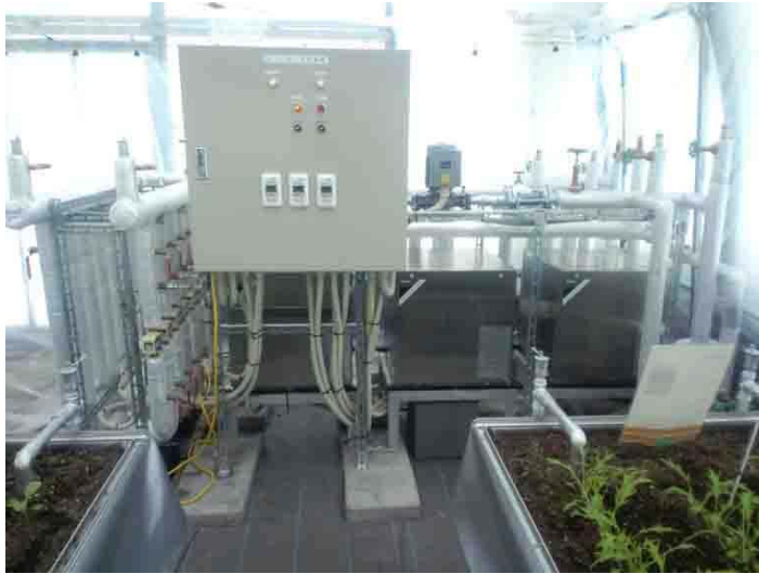
写真 2-13 ヒートポンプ及び配管
