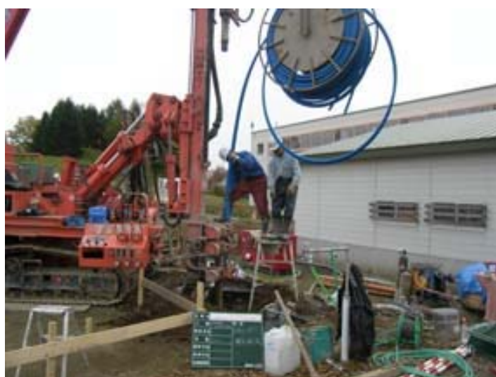
写真 2-2 Uチューブ挿入作業
