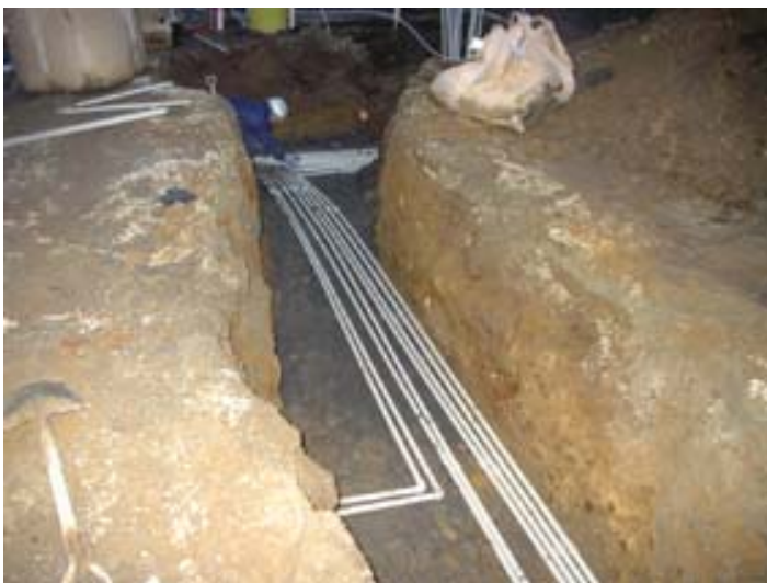
写真 2-6 外部配管作業
