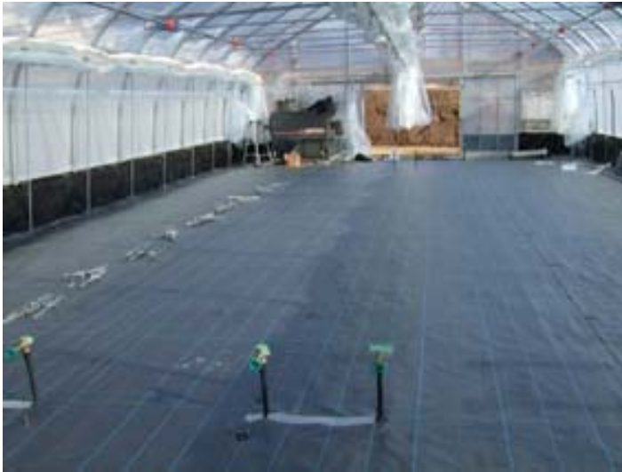
写真 2-10 グラウンドシート整備後の状況
