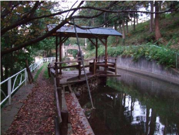
需要設備 (東屋)照明
