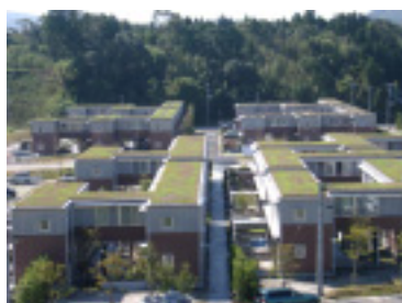
屋上緑化された団地の全 景
