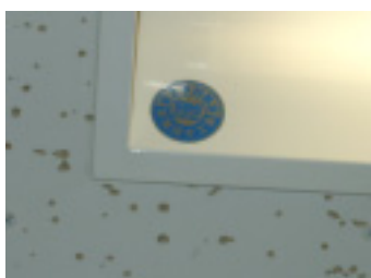
インバータを入れた蛍光灯にはシールが貼られる
