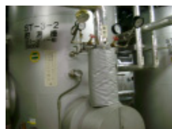
カバーを設けられたボイラーの配管
