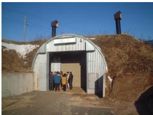
パイプアーチ型雪氷利用貯蔵庫 外観
