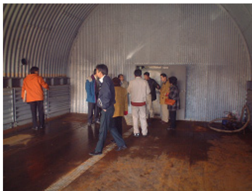
パイプアーチ型雪氷利用貯蔵庫 内部
