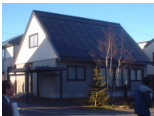
屋根と一体になった太陽電池
