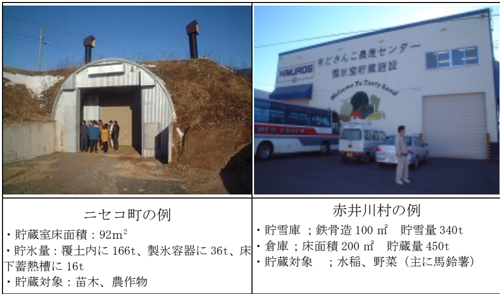
図 7-2-2 雪氷熱エネルギーを農作物等の貯蔵に利用した施設 (ニセコ町・赤井川村の事例)
