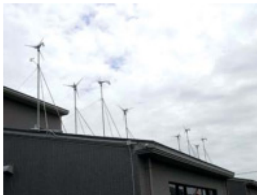
図5-3-8 発電量の計算に用いた小型風車の設置事例（神奈川県藤沢市鵠沼海岸） （ゼファー株式会社のホームページより引用）
