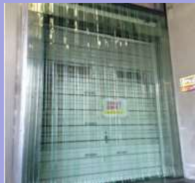
断熱ビニルカーテンの設置例
