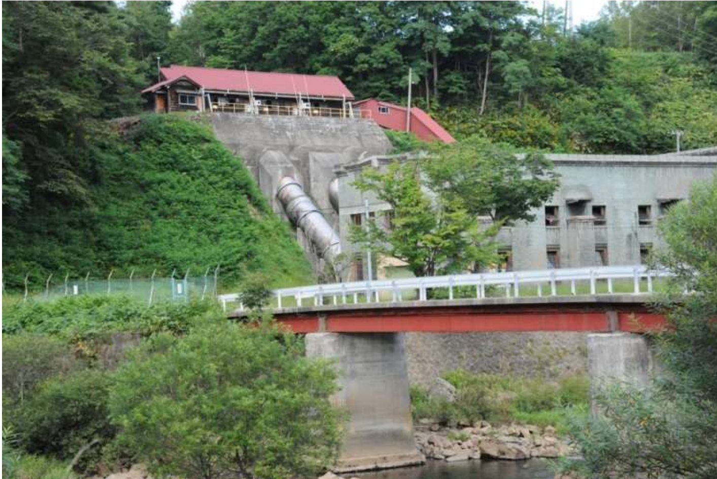
▲尻別川第1水力発電所
