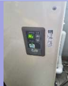
暖房ボイラーの設定状況（現地写真）
