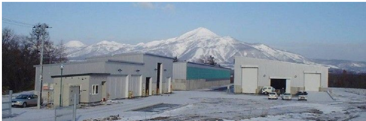
二セコ町堆肥センター
