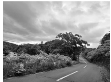
早期に改修が求められる危険箇所 (中央～有島間)
