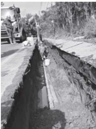
水道管工事(字羊蹄)
