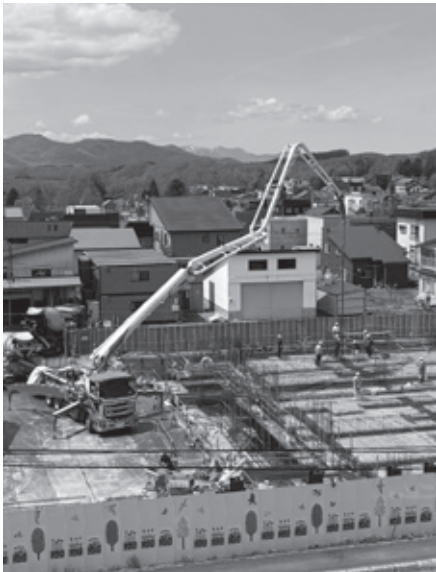
消防庁舎の建設現場（役場向かい）
