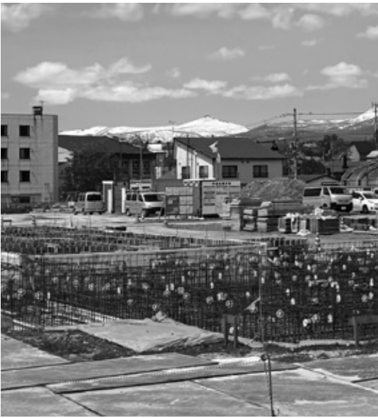
ニセコ高校新寮の建設現場（ニセコ中学校向かい）
