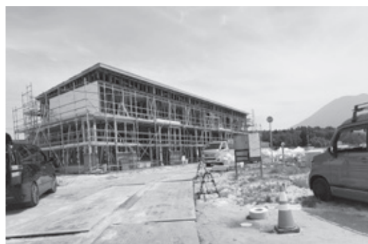
建設中の住宅
