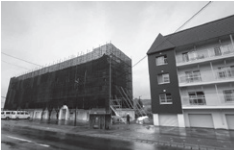
▲昨年改善工事が完了した中央団地6号棟 (右)と現在工事中の5号棟(左)
