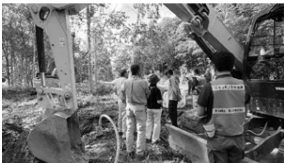
▲羊蹄地区の配水管更新工事現場を視察
