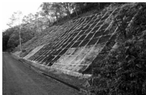
林道小花井線 法面補修工事
