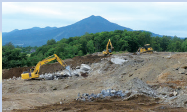
傾斜を解消して、一つのほ場にまとめる作業を行っている
