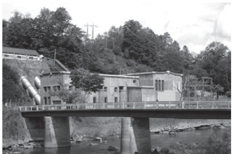
王子尻別第1発電所
