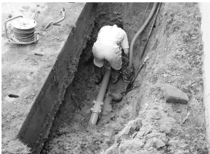
▲水道管修復工事
