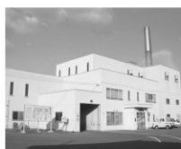
平成14年からニセコ町の燃やすごみを処理している横山町の焼却施設
