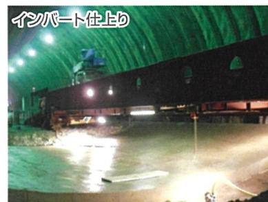
**STEP4** 覆工コンクリート打設
