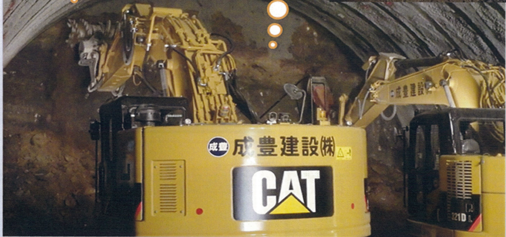
ツインヘッダーによる上半掘削状況 (BH1.2m 3 + MT3000)
