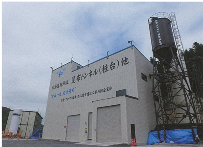
■吹付けプラント
