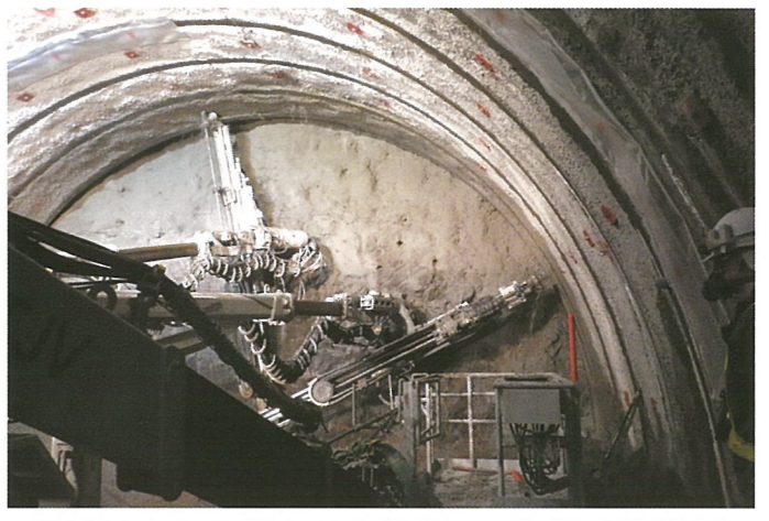
■ 吹付けコンクリート
