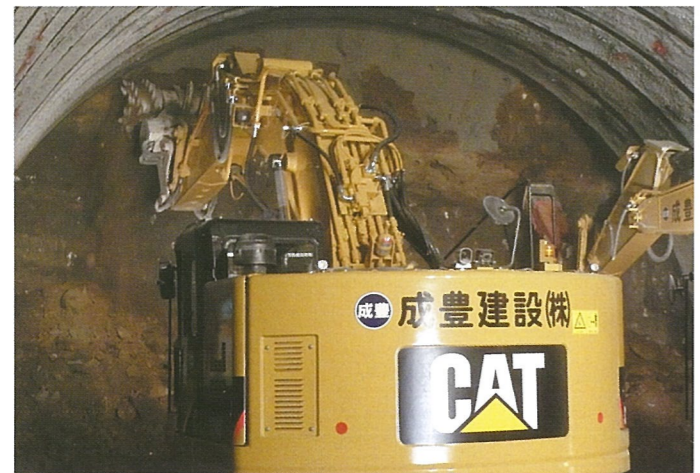
■ 上半掘削(機械掘削)
