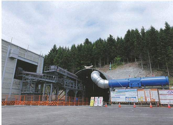
■トンネル坑口
