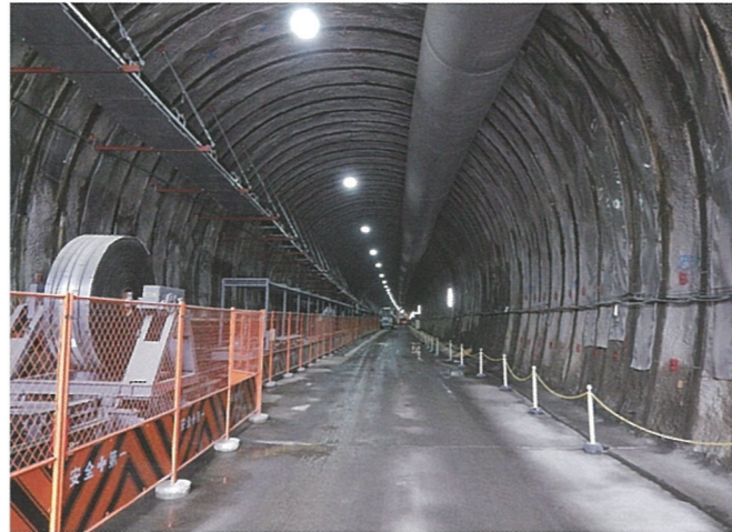
■トンネル坑内
