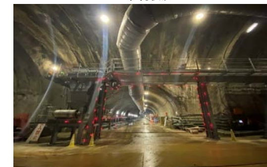
28.ニツ森トンネル(鹿子)他 覆工完了状況
