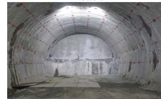
21.内浦トンネル(東川) 本坑状況
