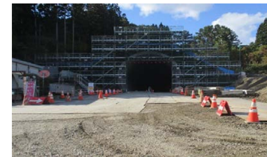
19.国縫トンネル他 切羽状況
