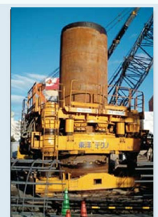
場所打ちコンクリート杭 全周回転式オールケーシング工法
