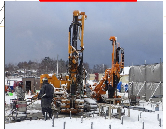
地盤改良の削孔機械
