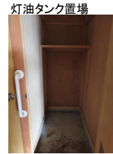
灯油タンク置場
