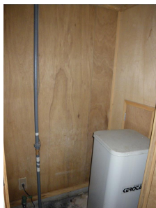
灯油タンク置き場
