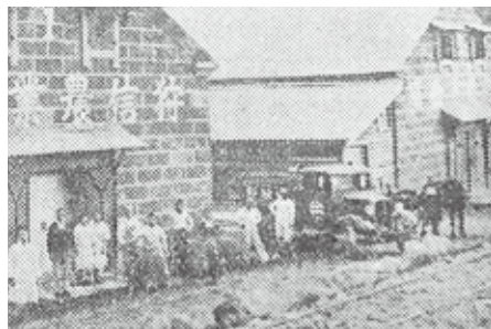
1930年代の2号倉庫。手前に簡易軌道のレールが見える
