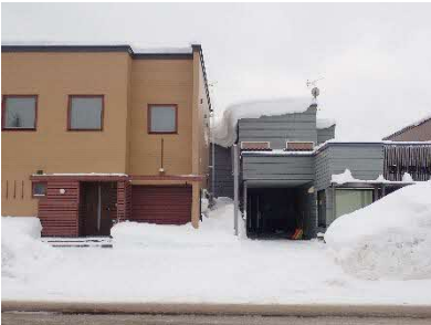
玄関アプローチを兼ねたカーポート
