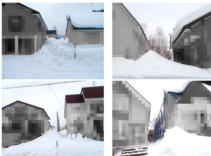
図 隣棟間隔が狭い事例（2022（令和4）年1月撮影 加工写真）
