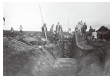
灌漑溝工事。水温を上げるため「斜段」という落差を設けた。右端は吉川銀之丞
