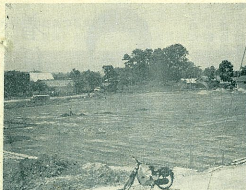
←写真は町民スポーツ大会をひかえ急ピッチで工事を進めている町民運動場（8月21日撮影）
