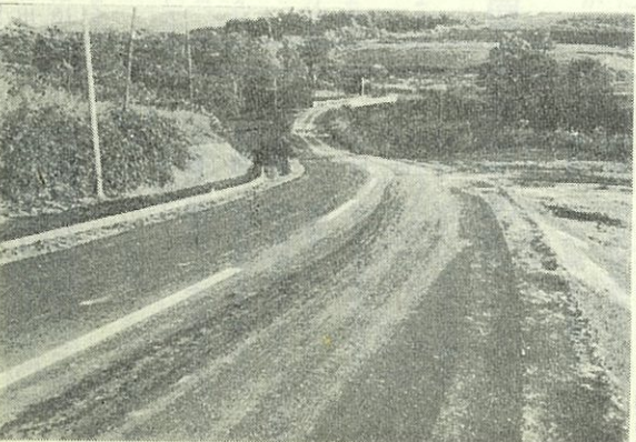
【ルベンベ通道路局部改良舗装】
