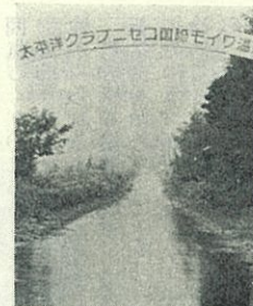
ニセコ藻岩下線舗装工事
