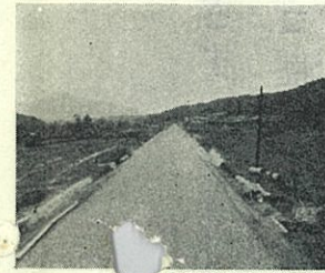
上昆布道路局部改良工事
