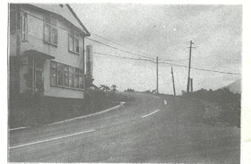
田下通舗装新設工事
