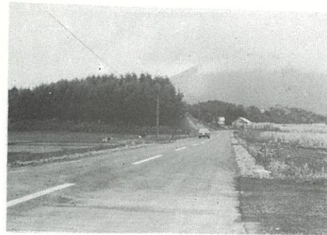
有島北一線舗装新設工事
