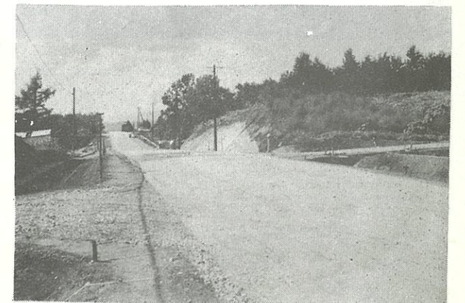
真狩旧道線凍雪害防止工事 (9月20日完成予定)
