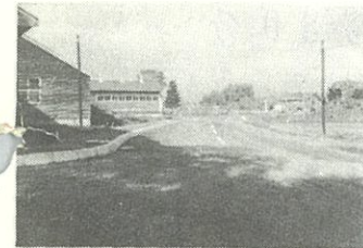
○真狩旧道線道路局改良舗装工事
