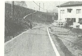
○芙蓉荘前道路局改良舗装工事
