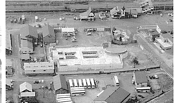
▲来春オープンに向け、工事の中央地区温泉施設
