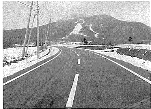
▶改良舗装が施された町道一線
