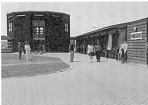
▲今年度改修を予定している道の駅ニセコビュープラザ
