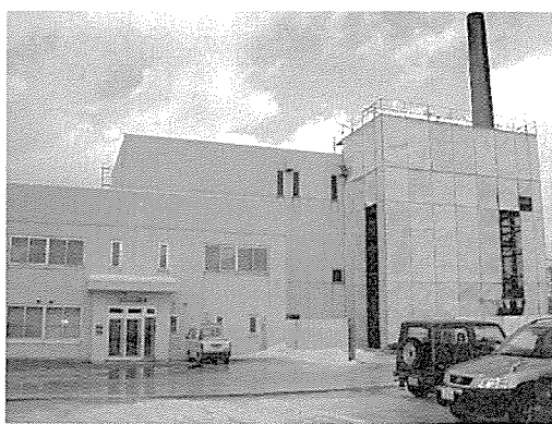
▲改修が進む倶知安町清掃センター
