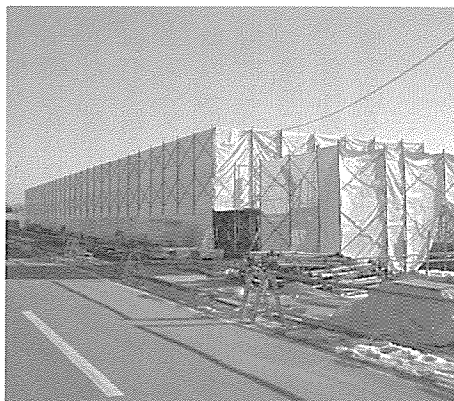
▲建て替えが進む本通A団地（6戸）
