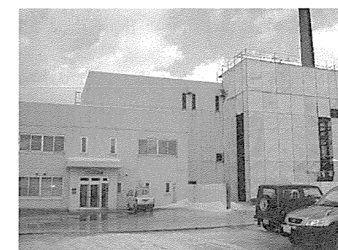
▲改造が進む倶知安町清掃センター
