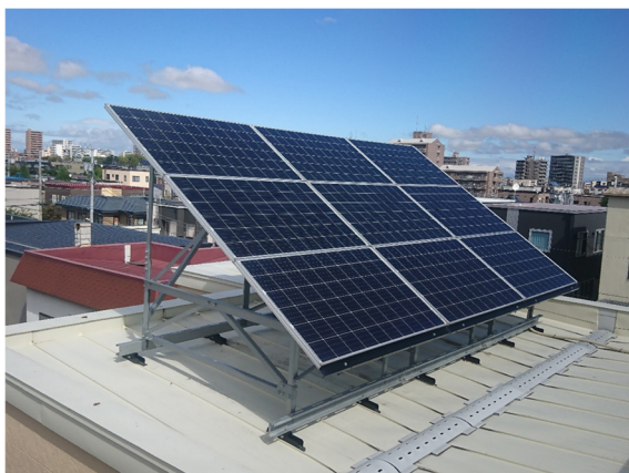
住宅屋根上への設置事例
