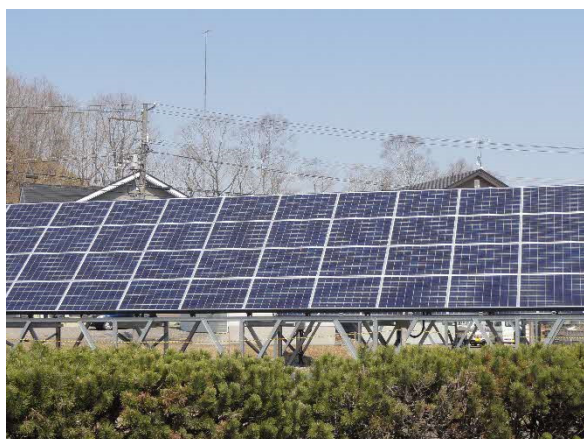
野立てにおける設置事例
