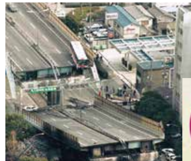
阪神・淡路大震災(崩壊した阪神高速道路) 平成7年(1995) 写真提供:神戸新聞社
