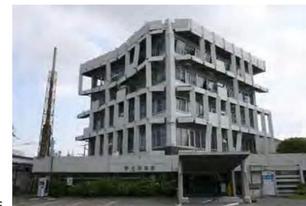
立ち入り禁止となった宇土市役所庁舎
