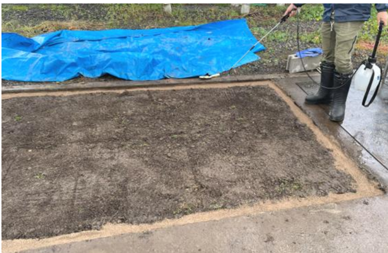
写真：乾燥砂への散水の様子、敷き詰め後に散水すると砂が締まり、施工性が向上する
