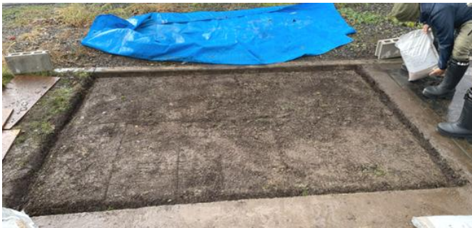
写真：（左） 施工場所端部に溝をつけた状態、（右） 乾燥砂の敷き詰めの様子
