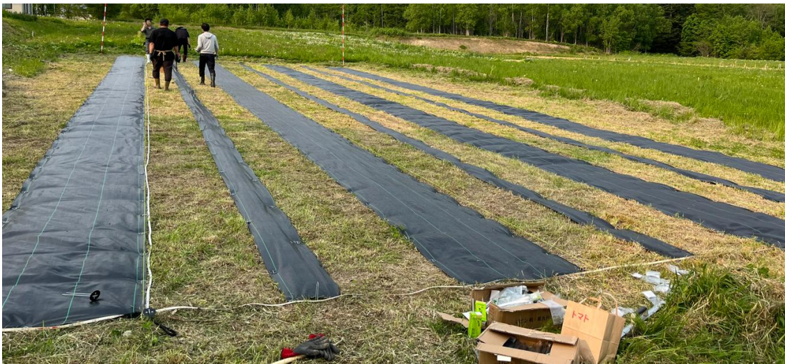
写真：防草シート施工
