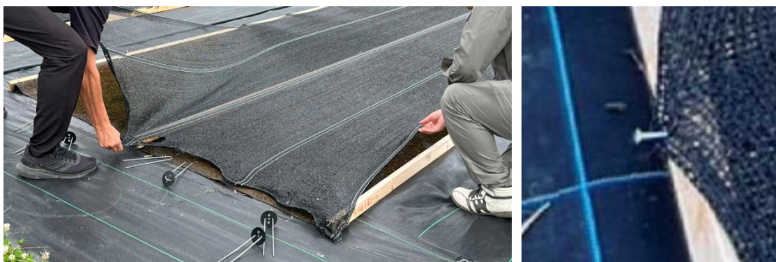
写真：遮光ネット設置
