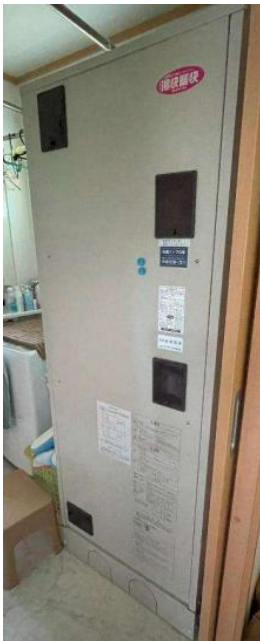
写真：温水熱源機式の給湯・暖房一体型機器の事例
