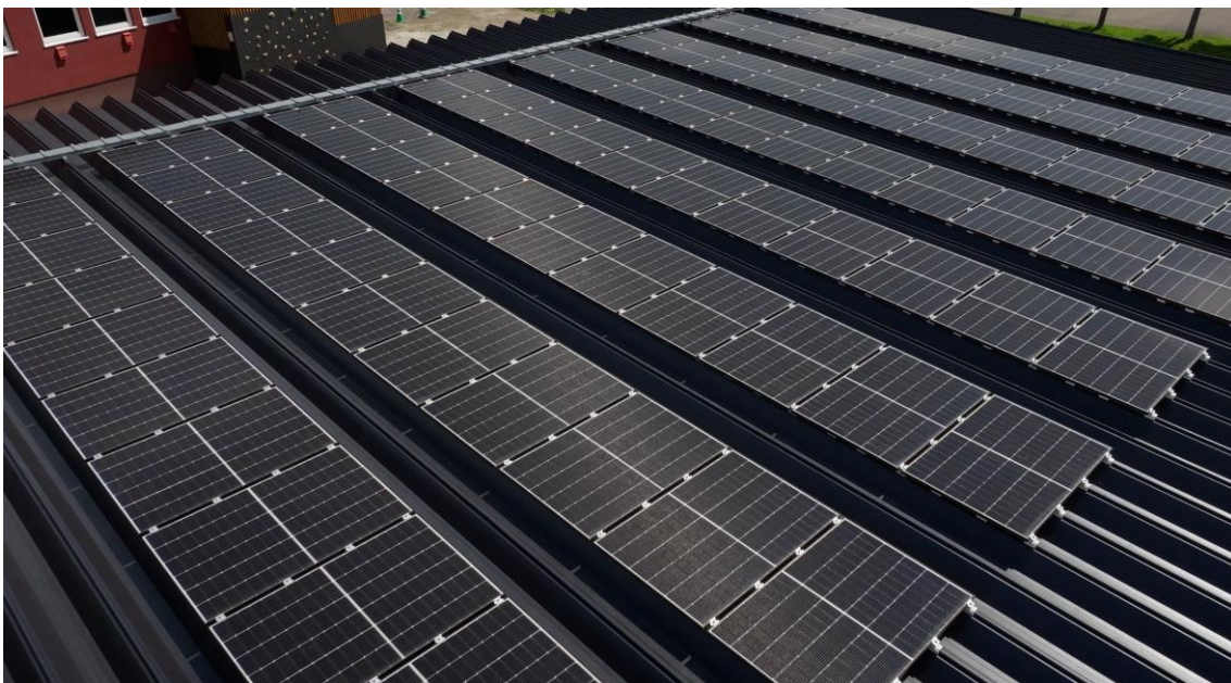
写真：モクレニセコ A 棟に電力を供給しているソーラーカーポートに設置されている 88 枚の太陽光発電パネル
