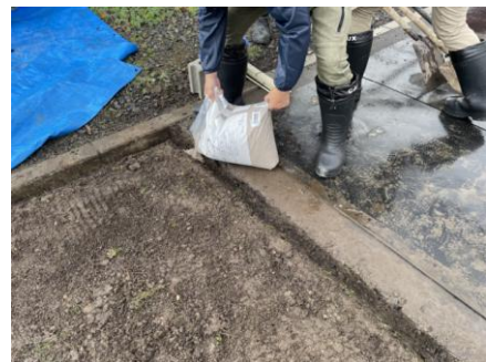
写真：（左） 施工場所端部に溝をつけた状態、（右） 乾燥砂の敷き詰めの様子
