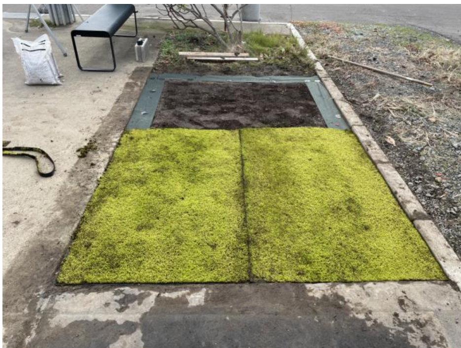
写真：田の字型に防草シートを施工。4分割した苔シートを施工するため田の字型に防草シートを設置
