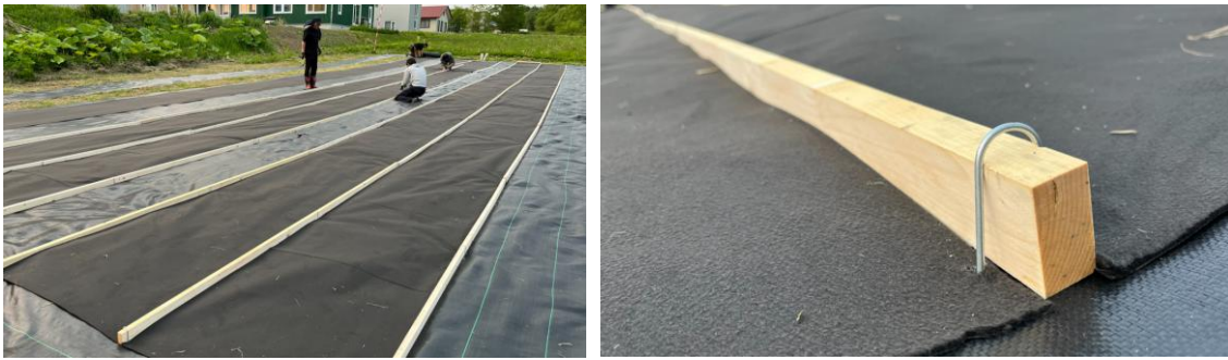
写真：(左) 防草シート施工後に植生シートを施工、(右) Uピンでの固定
