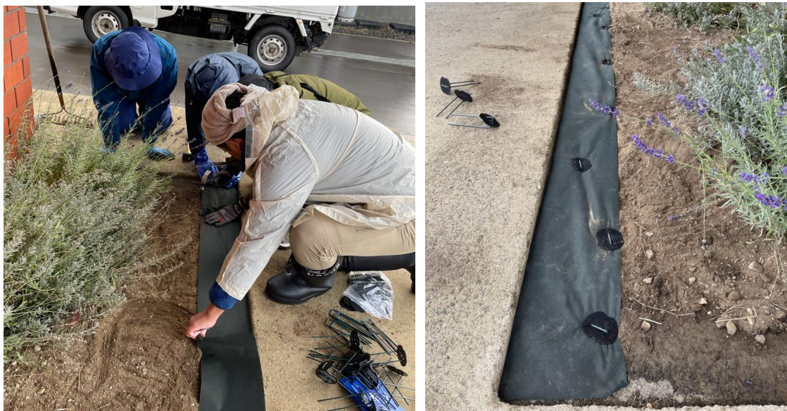
写真：防草シート施工
