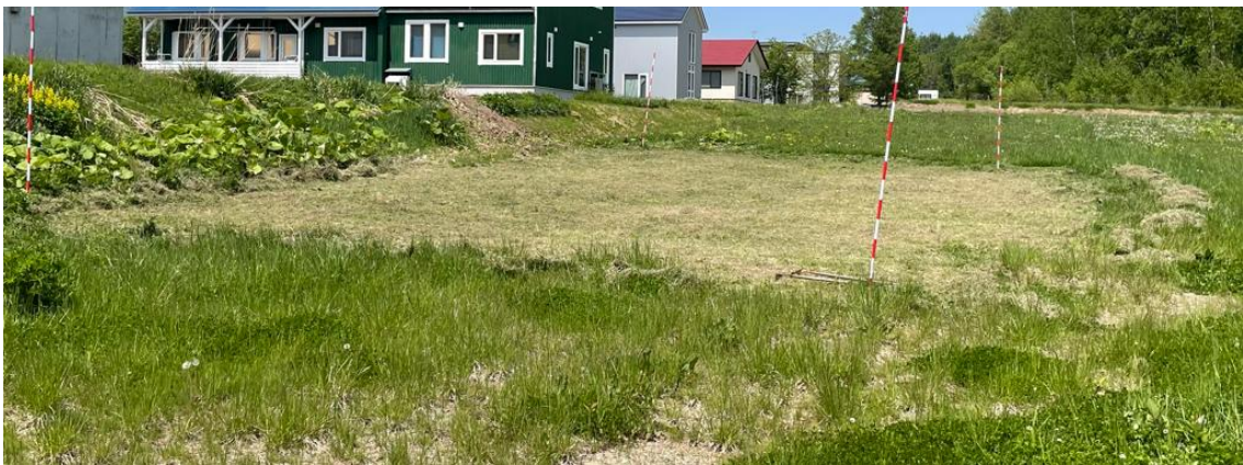
写真：草刈り 2 回実施後、刈り取った雑草や凹凸の原因となる草の根、石を除去する
