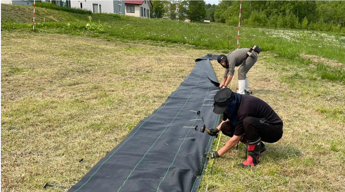
写真：防草シートの施工
