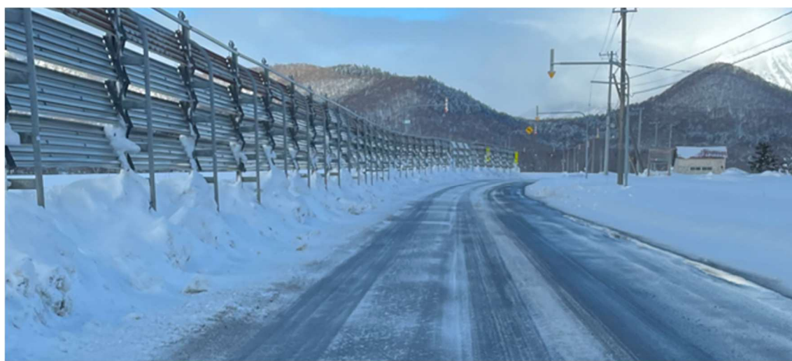
写真：冬季走行実験時の洞爺湖周辺の路面（当日、ニセコは除雪後の圧雪路面、洞爺湖は一部路面が露出、伊達・室蘭は乾燥路面）。冬季でも除雪後であれば時速40~50kmで走行可
