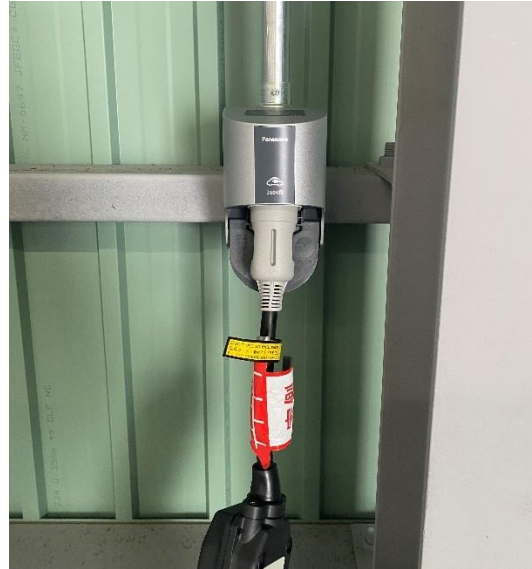
図：ソーラーカーポートに設置されたカーシェアと充電コンセント
