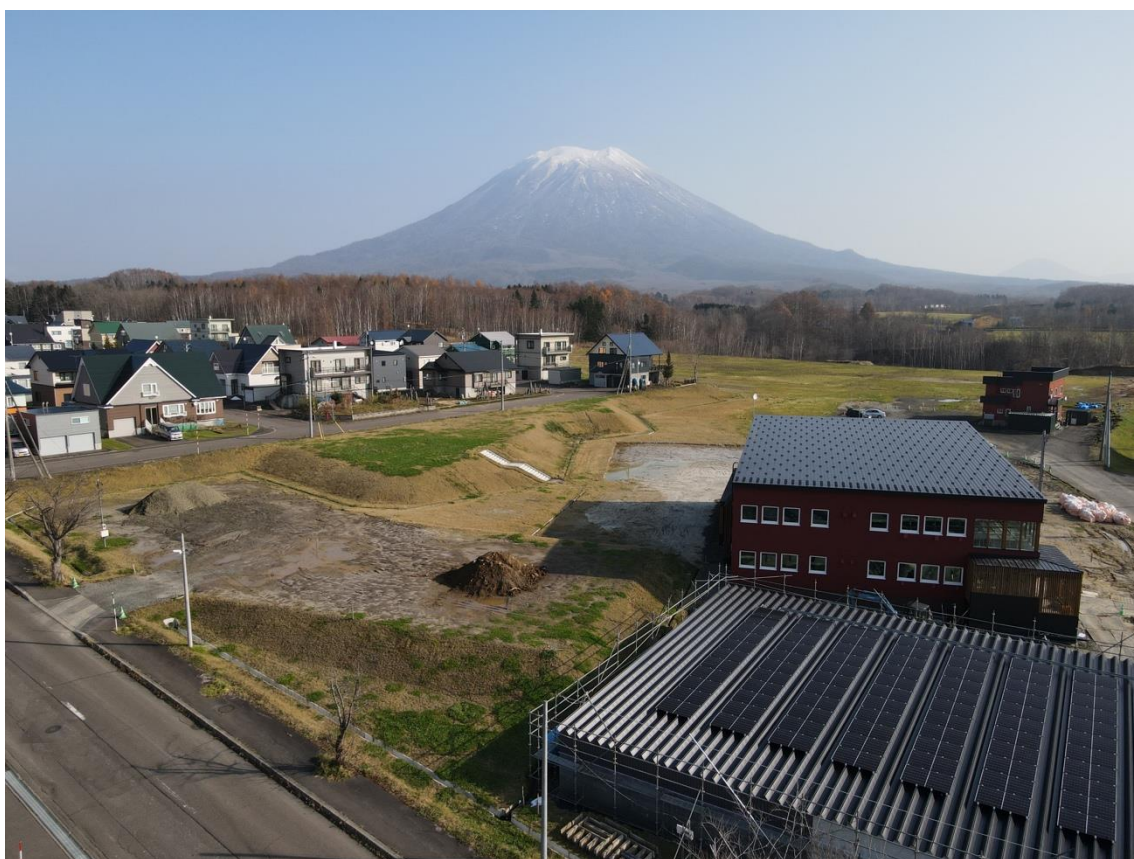
図：ニセコミライ ソーラーカーポート 空撮写真（一例）
