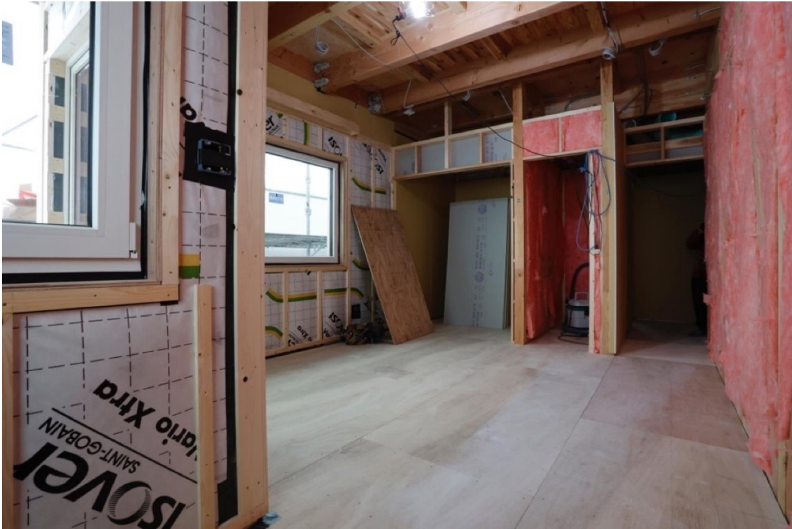
写真：ニセコ町内の建築現場の内観
