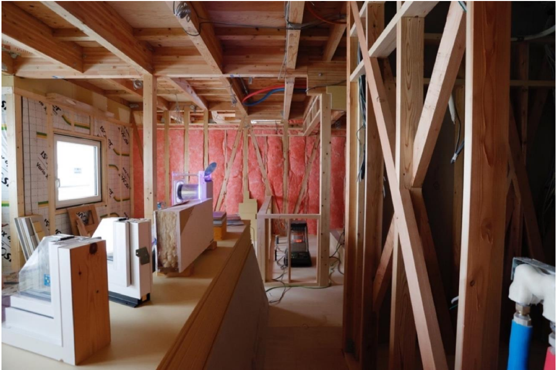
写真：ニセコ町内の建築現場の内観
