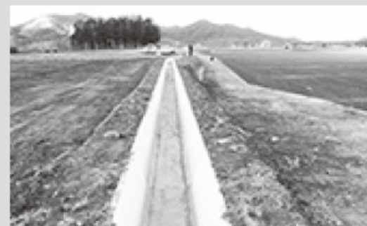
整備後の用水路のようす
